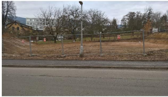
PŘÍPRAVA STAVENÍŠTĚ DLE POV 4 týdny před montáží
