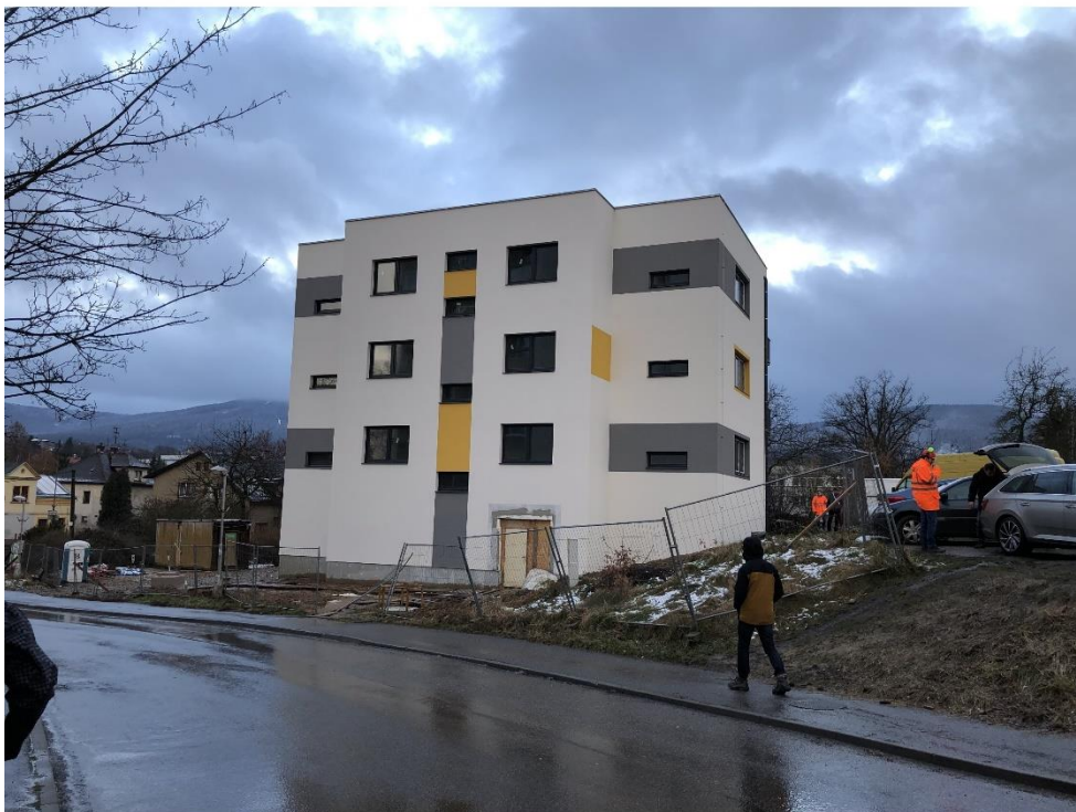
DOKONČENÁ HRUBÁ STAVBA 9 týdnů po montáži, celková doba realizace hrubé stavby - 16 týdnů
