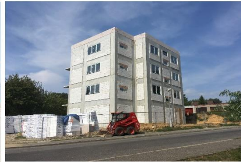
KONSTRUKCE SKELETSYSTEM S VYZDÍVKAMI 4 týdny po montáži
