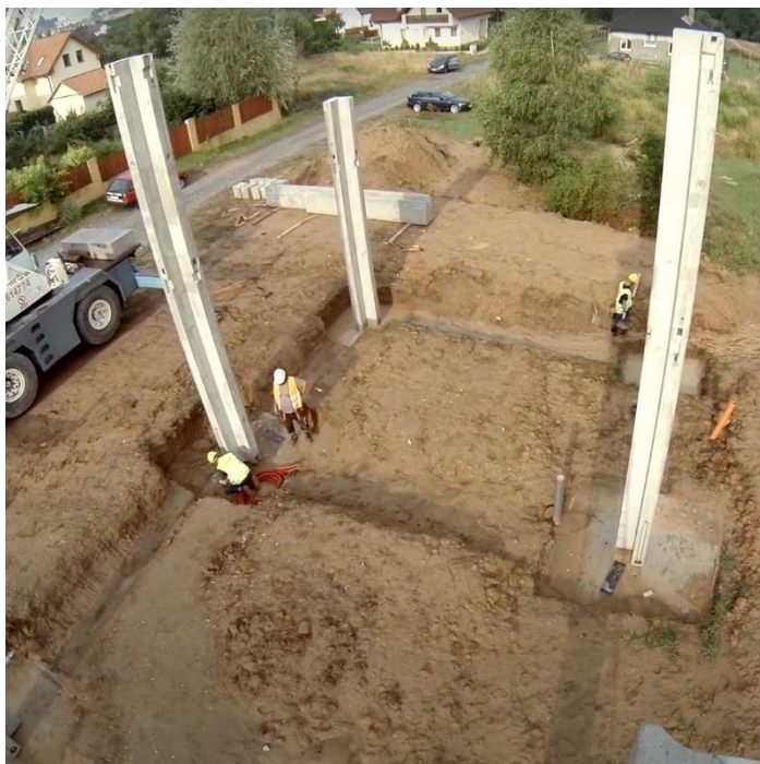
ZALOŽENÍ NA PATKÁCH - ZAHÁJENÍ MONTÁŽE
