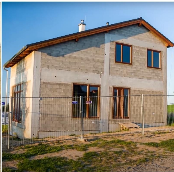
DOKONČENÁ HRUBÁ STAVBA
