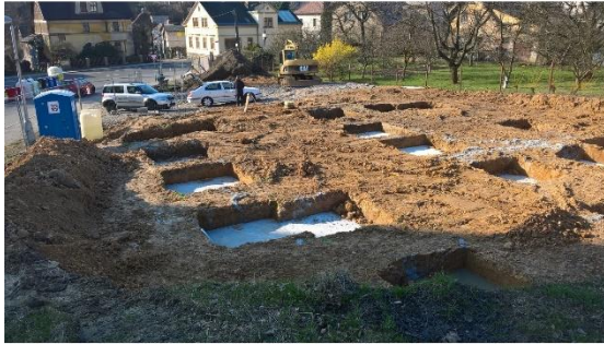
REALIZACE ZÁKLADOVÝCH KONSTRUKCÍ 2 týdny před montáží
