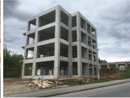
MONTÁŽ KONSTRUKCE SKELETSYSTEM 6 týdnů od zahájení
