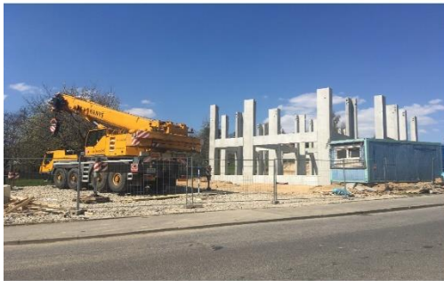
MONTÁŽ KONSTRUKCE SKELETSYSTEM 2. týden montáže
