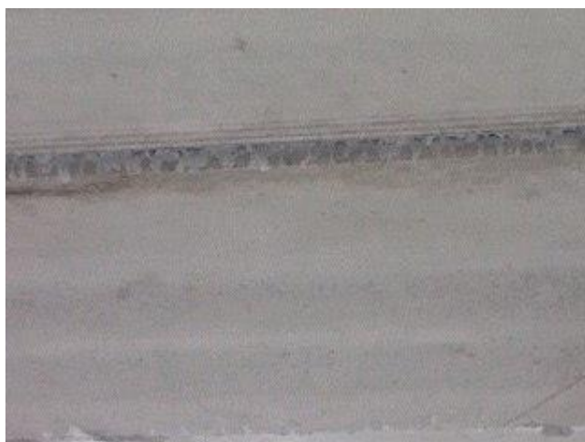
Obr. 21 – ukázka nerovnosti spodního povrchu stropní konstrukce
