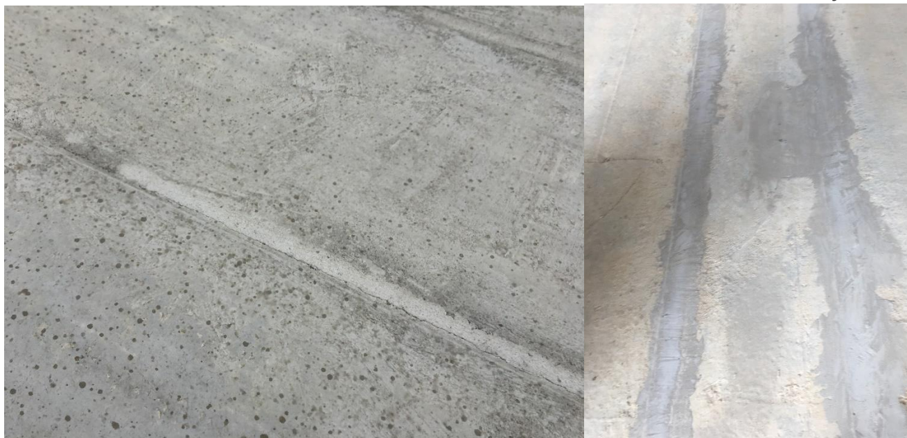
Obr. 4 – horní líc dílců Spiroll – zvlněný povrch
