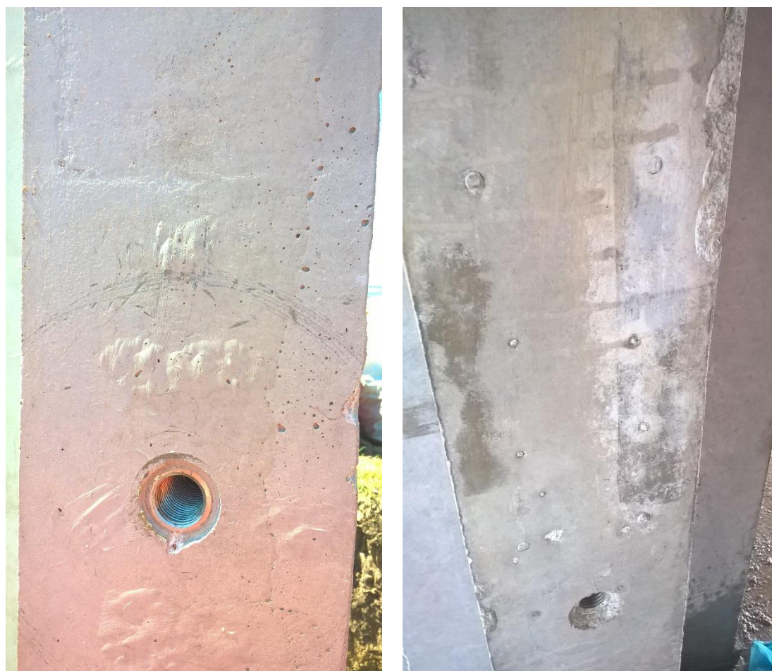
Obr. 14 – ukázka povrchu prefabrikátu ze strany od bednění
