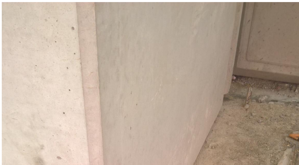
Obr. 17 – hrana tvarovaná pomocí trojúhelníkové lišty
