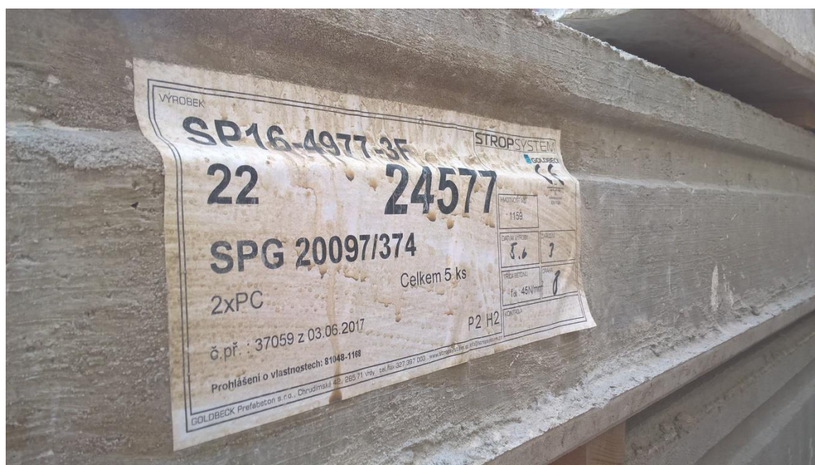
Obr. 5 – bok dílce Spiroll – přirozeně drsný vlivem výrobního procesu, štítek vždy nalepen z boku dílce
