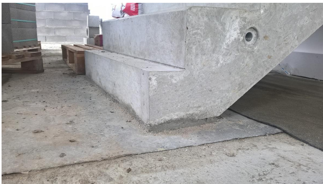
Obr. 8 – bok schodišťového dílce včetně manipulačního závěsu
