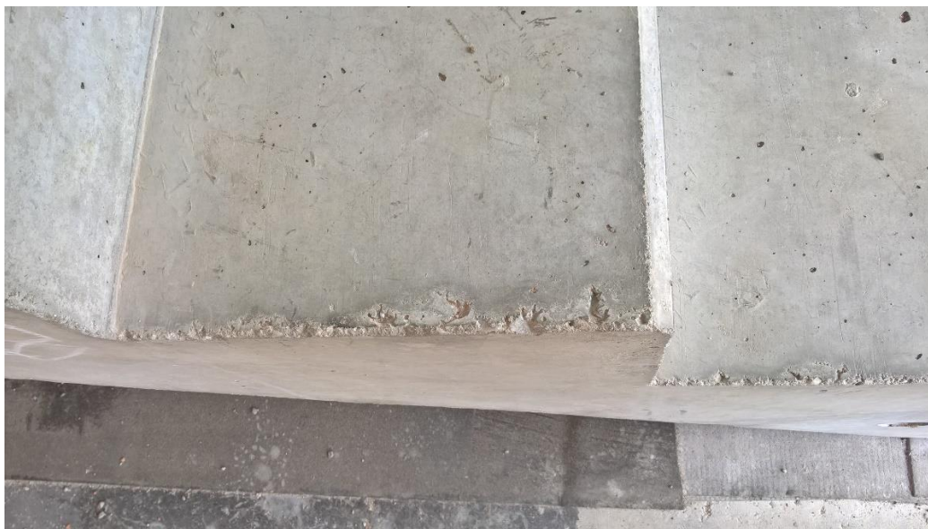
Obr. 7 – boční a vrchní hrana schodišťového dílce
