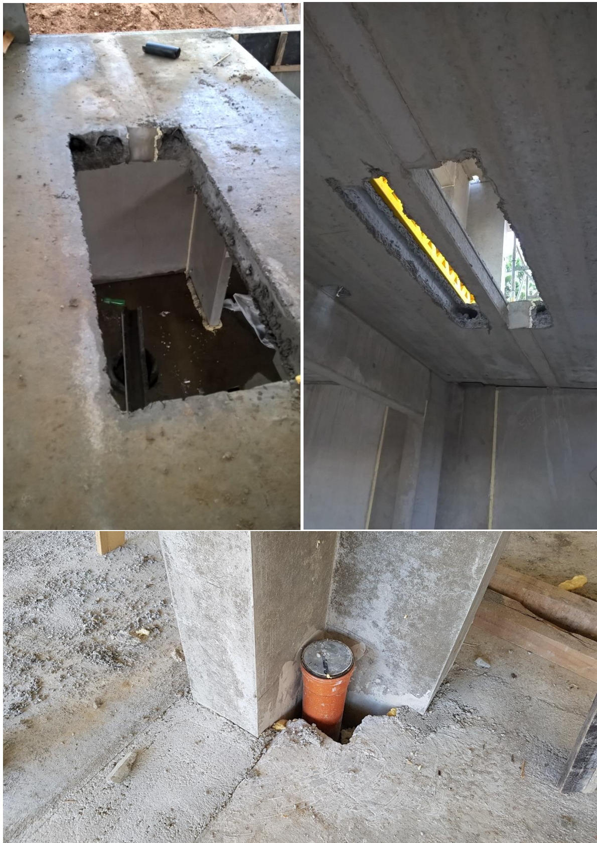
Obr. 2 – výhraby v dílcích Spiroll
